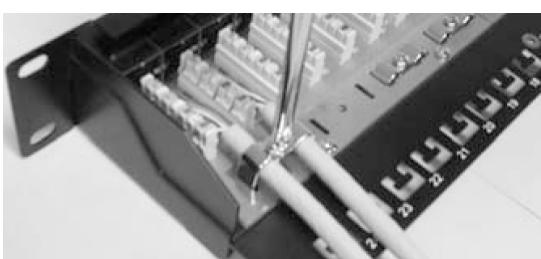
Затяните винты через металлический корпус для крепления двух кабельных оболочек.
